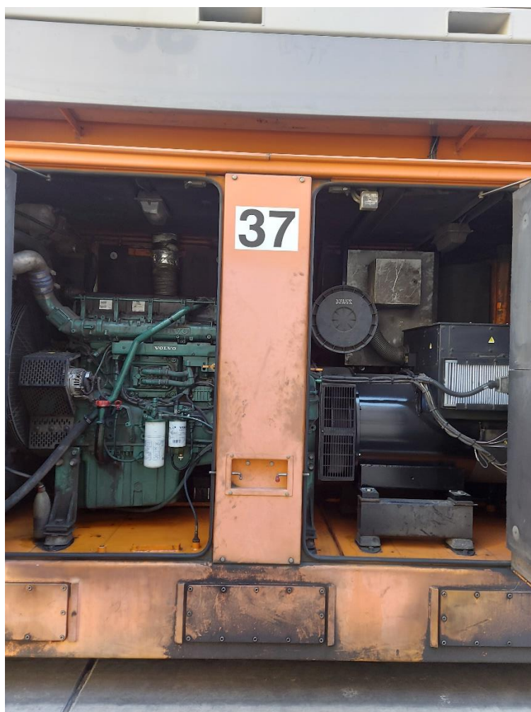
Slika 1: Strojnica RTG 37 ( pogonski agregat in generator)
